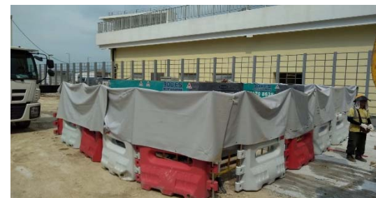
增添防護隔音屏障
