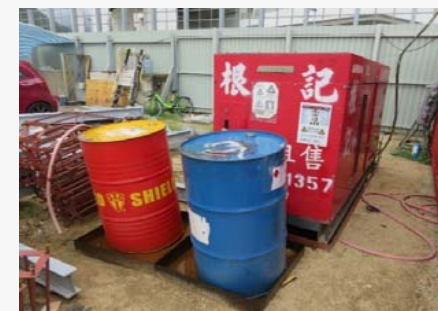
化學物品儲放於儲漏盤
